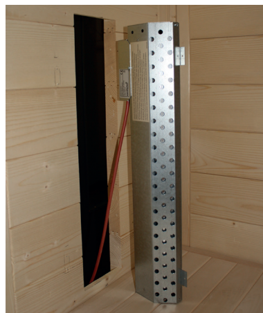
rys. 2: Pozycja skrzynki przyłączowej
